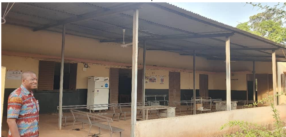
El hangar de vacunación construido en el CSCOM de Wayerma1 por el proyecto financiado por la AECID.
