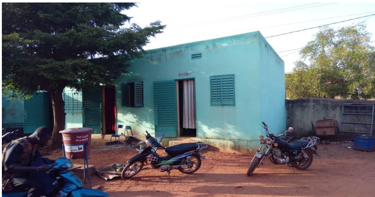
Salle de garde construite au CSCOM de Sanoubougou1
