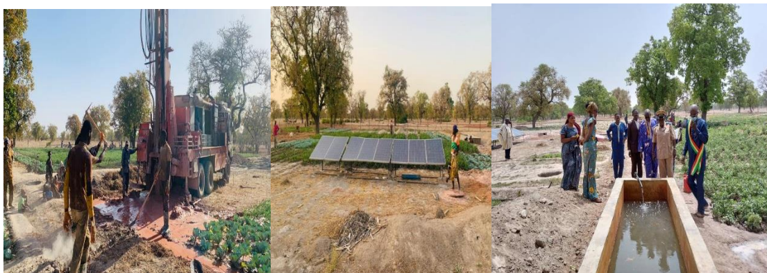
Fotos del pozo sondeo de Nizanso: de la operación de sondeo a la inauguración
