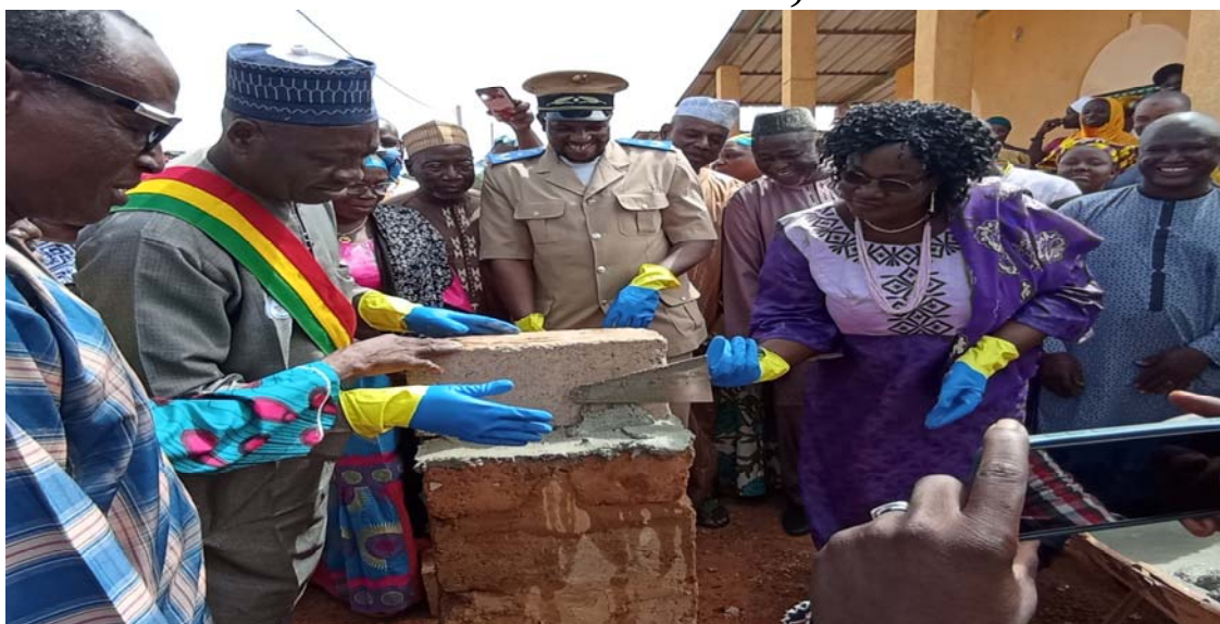
Colocación de la primera piedra del muro del CSCOM de Mamassoni
