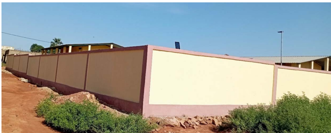
El muro perimetral del CSCOM de Mamassoni construido por MZC con financiación de la AACID
