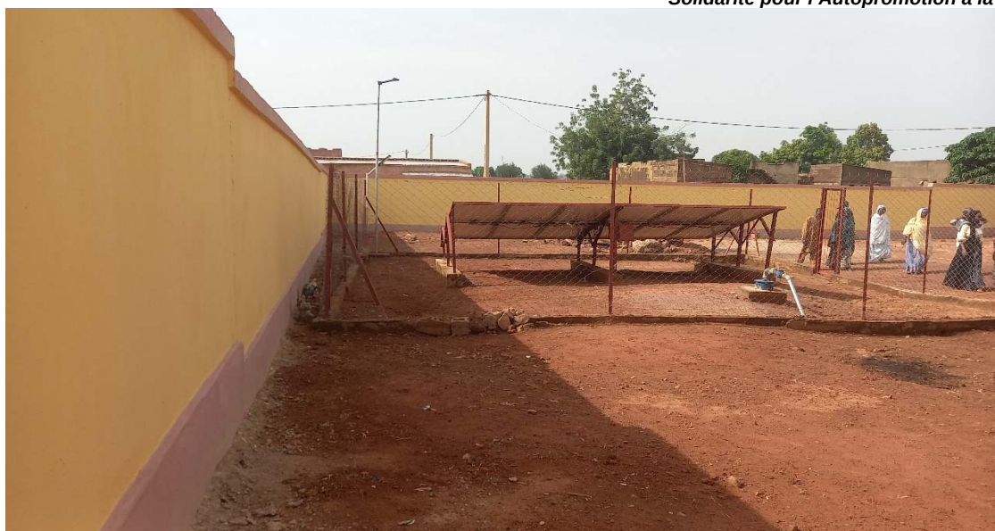
Interior del muro de cerramiento construido por el proyecto, así como instalaciones solares en la parte superior e inferior.
