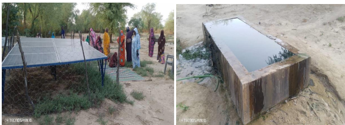
Una fuente de agua instalada por MZC con paneles solares.
