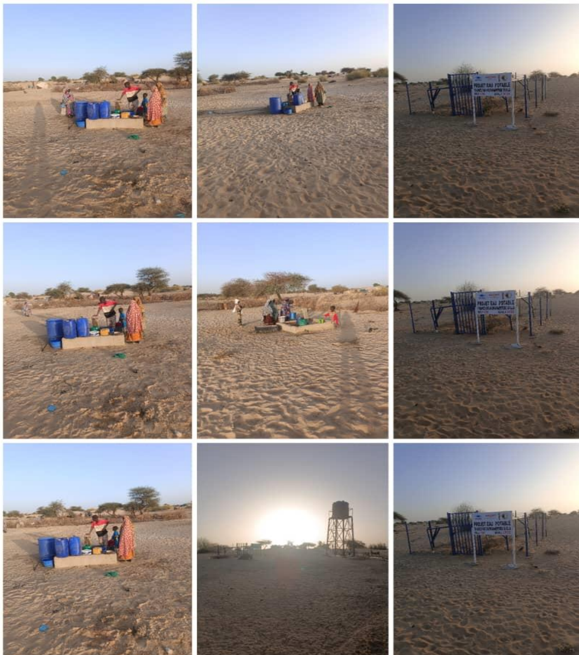
Fotos de los pozos realizados del P.S.72
